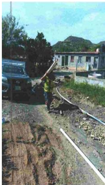
Colocar 350 mt de tubería en Col. Balcones del Mirador
